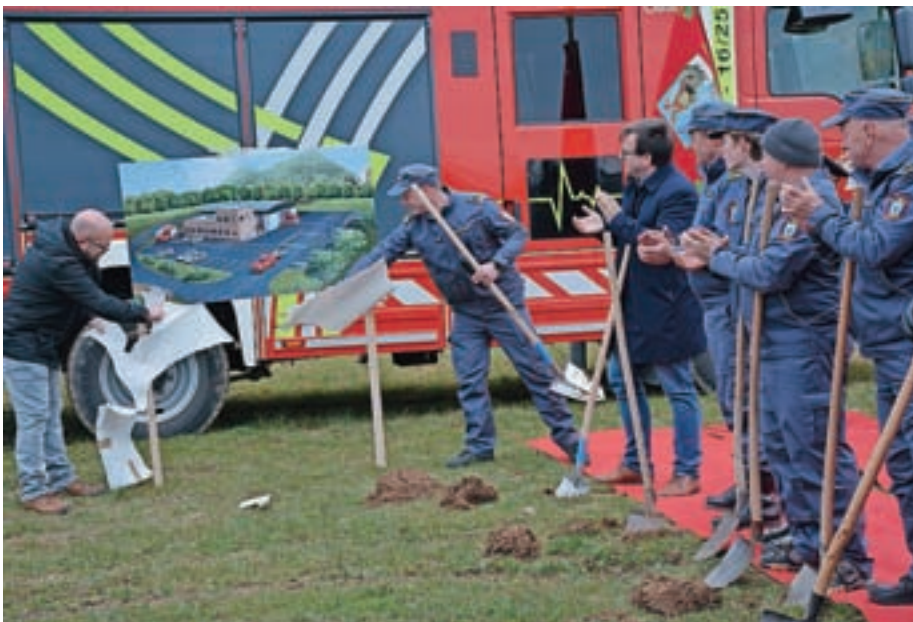
Gradnja novega gasilskega doma se je začela. Ob dogodku, na katerem so simbolično zasadili prve lopate, sta podoba novega doma odkrila Matej Meznarič, predsednik PGD Zgornje Pirniče (desno), in projektant Robert Robas. / Foto: Maja Bertoncelej
